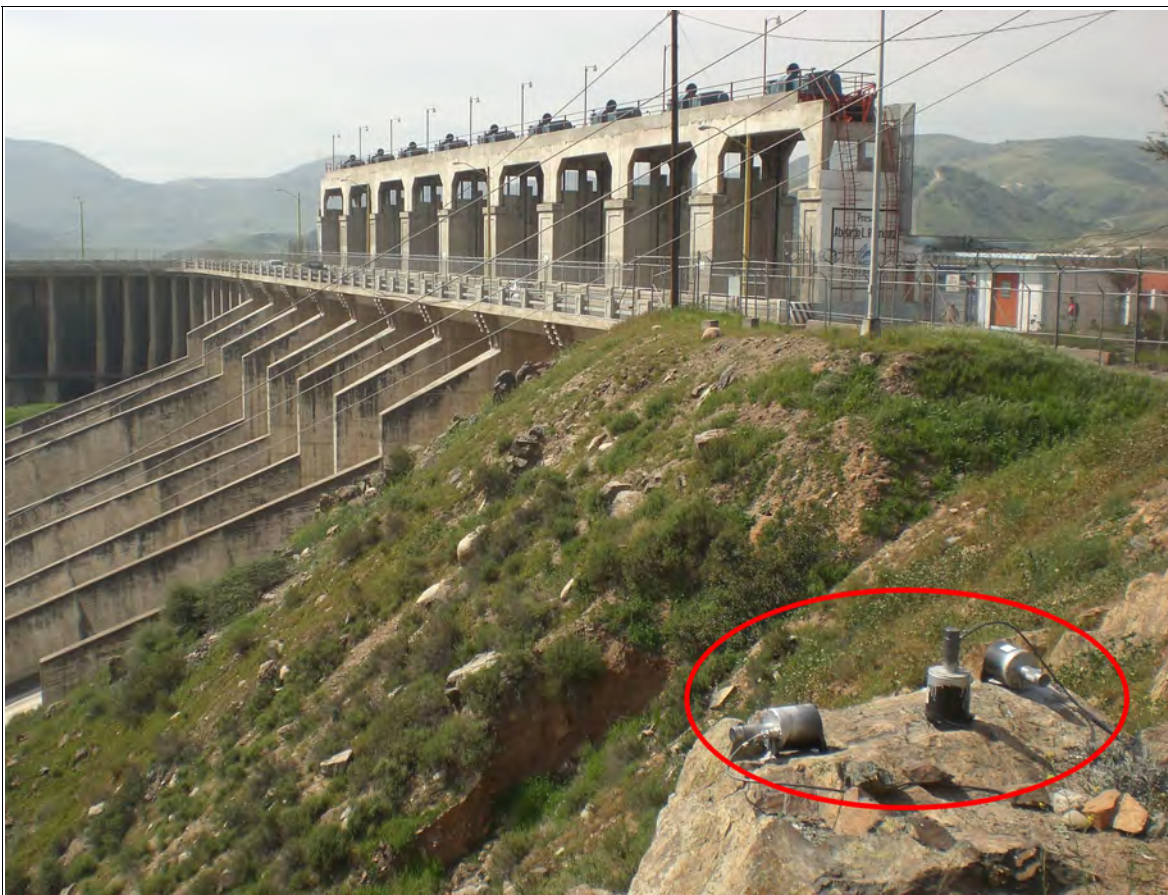
Figuras 20.a (arriba) y 20.b. Detalle de la ubicación de la estación CNA.
